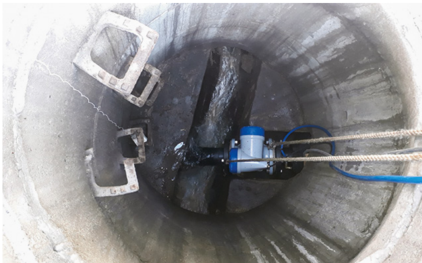
Fig. 4 Messung in einem Nebkanal mit viel Wasser
