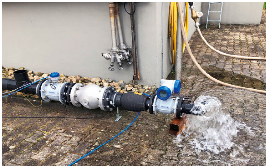
Fig. 3 Messkontrolle mit Wasserzähler
