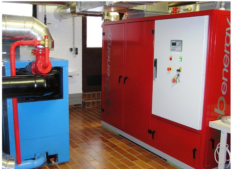
**Bild 15:** BHKW-Modul 50 kW
