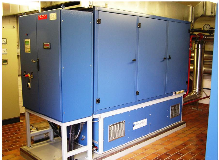
**Bild 16:** BHKW-Modul 80 kW
