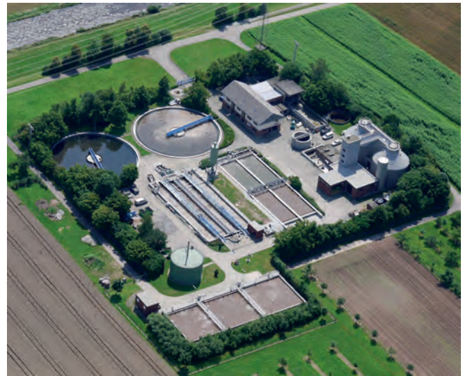
Abb. 1: Luftbild der Kläranlage Biberach von 2009
