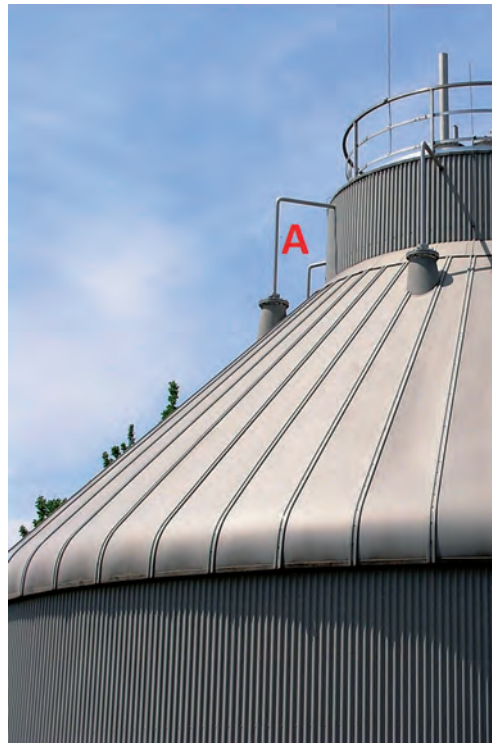
Abb. 11: Gas-Einpresslanze
