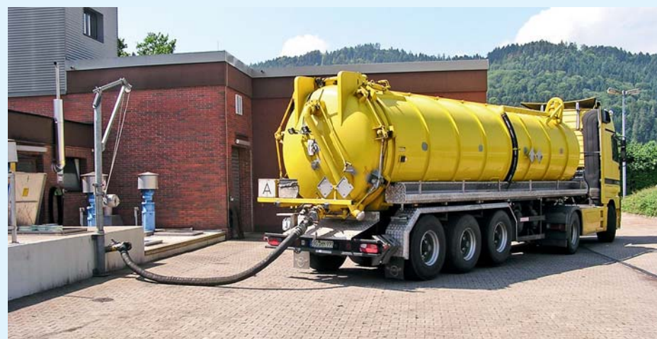
Der alte Fäkalienspeicher wurde zum Gärsubstratspeicher Bild 8
