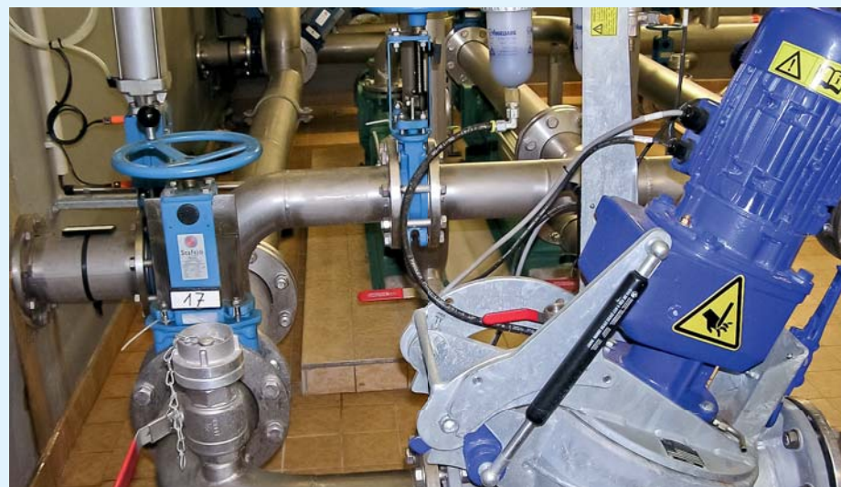
Zerkleinerer verhindern das Eindringen von Sperrstoffen in die Faulbehälter Bild 7
