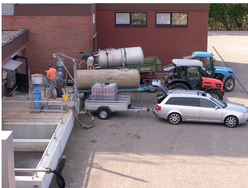
Bild 6. Annahme- station Brenn- schlempe und Gärsubstrat.
