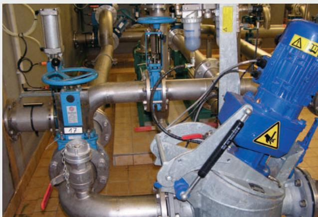
Fig. 8 Faulbehälter-Beschickungspumpe mit Zerkleinerer (unten rechts), Leitung fürs Gärsubstrat (links aussen) und Pneumatikschiebern (oben links)
